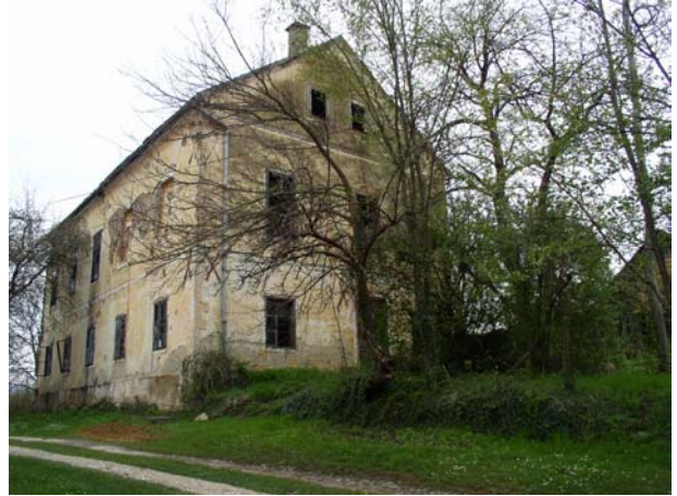
1.1.4. Žakanje, zgrada škole
